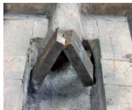
c. 羽口の取り付けと火窓の成形
